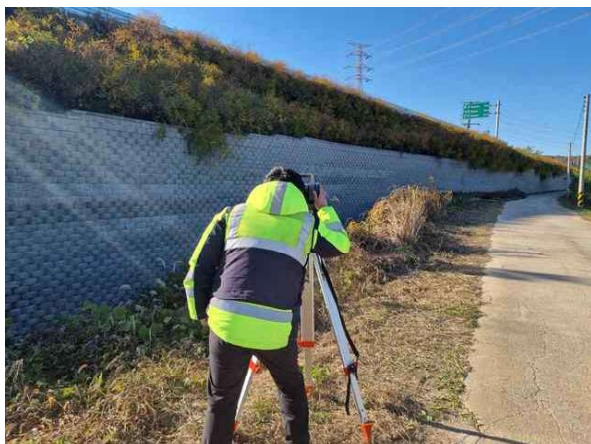
광파기를 이용한 측량 작업
