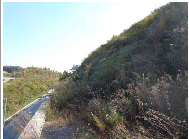
상부 절토부 전경
