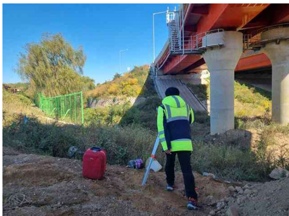
광파기를 이용한 측량 작업
