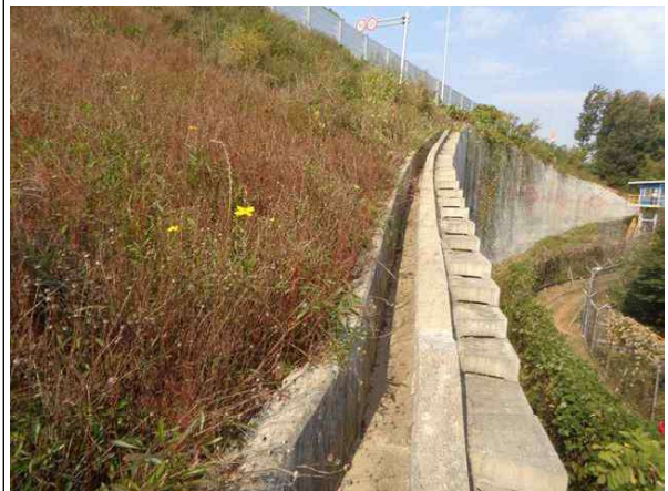
상부 성토부 전경
