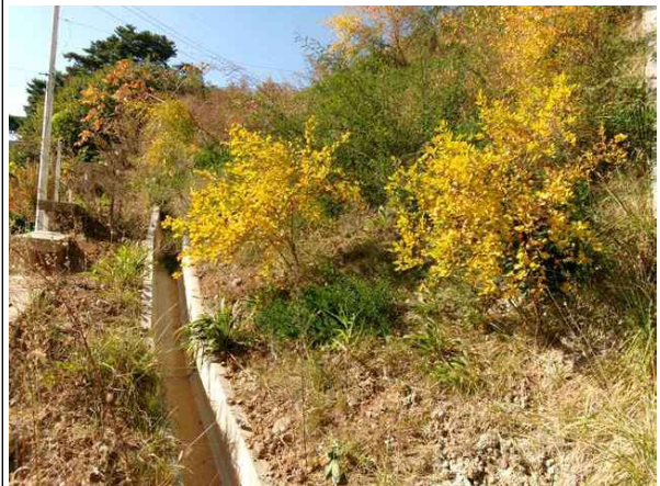
상부 성토부 전경
