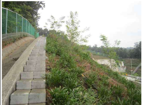
상부 절토부 전경
