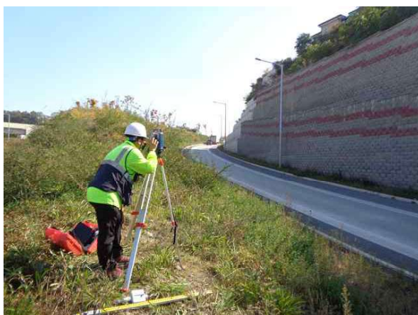
광파기를 이용한 측량 작업
