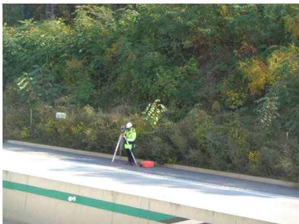
광파기를 이용한 측량 작업
