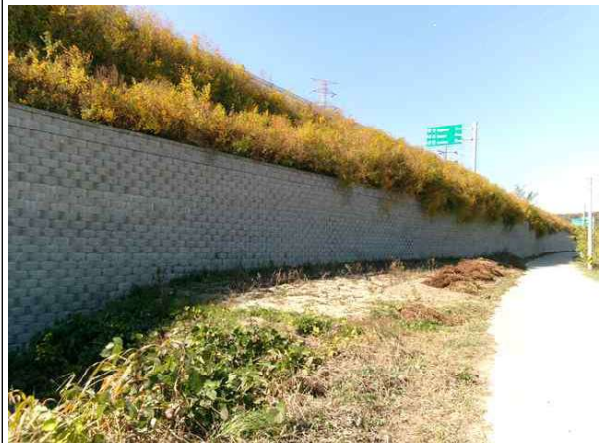
상부 성토부 전경
