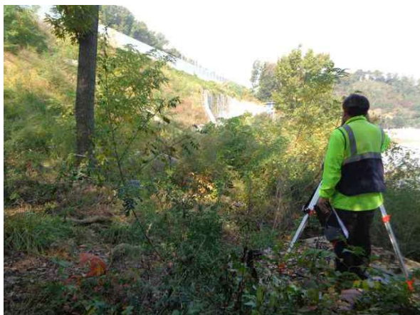
광파기를 이용한 측량 작업
