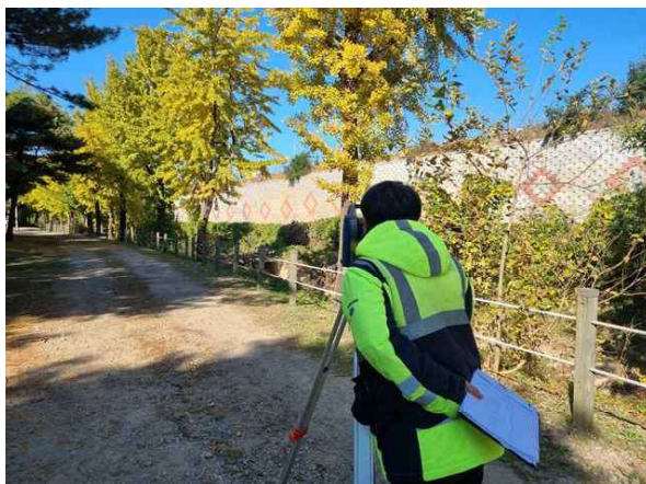
광파기를 이용한 측량 작업
