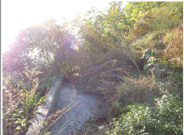
상부 절토부 전경
