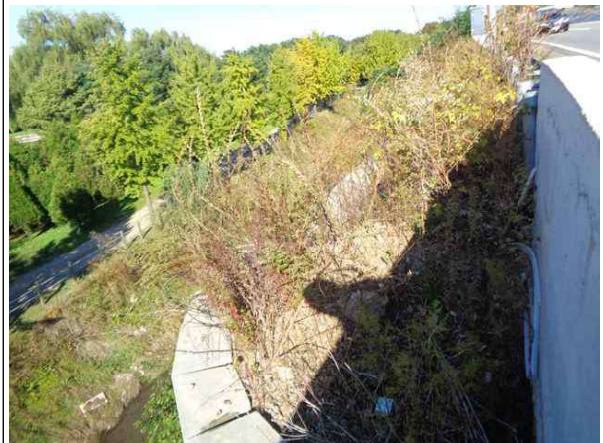
상부 성토부 전경
